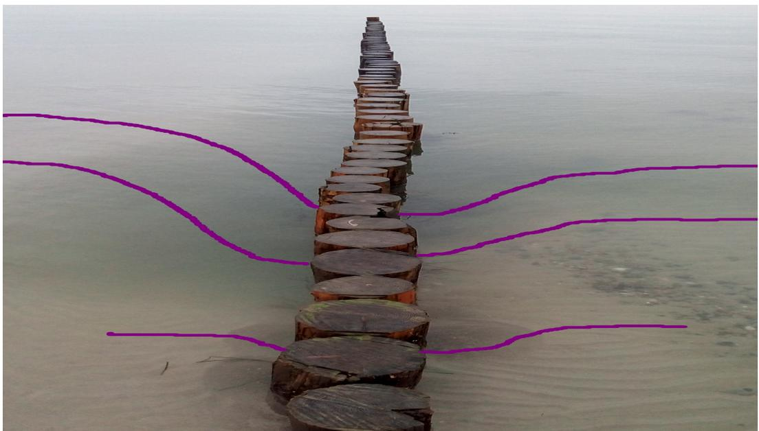
Kurz nach einer kräftigeren Durchströmung sind im stillen Wasser die Strömungstrichter beidseits einer Pfahlreihe zu erkennen. Allerdings sind diese bei größeren Böschungswinkeln, die sich dynamisch während der Durchströmung einstellen, nicht stabil. Schnell fallen diese Strömungstrichter wieder zusammen. Zuletzt zeigt sich der Seeboden wieder auf beiden Seiten einer jeden Pfahlreihe topfeben, als wäre der beschriebene Effekt gar nicht gewesen.
