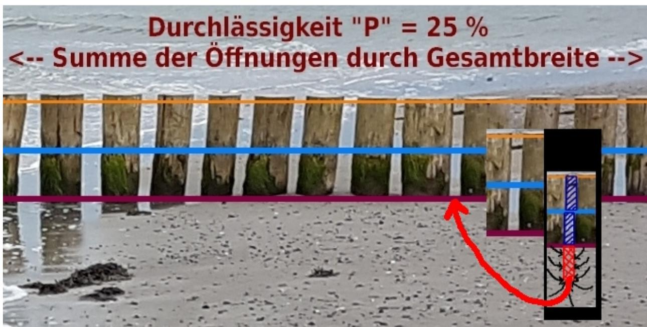
Die blaue Linie entspricht dem mittleren Wasserstand NN (Normal-Null). Orange ist die Oberkante, bis zu der die Buhnen überhaupt wirken können. Je höher die Wasserstände ausfallen, um so geringer ist der Wirkanteil der Buhnen in Bezug auf Wasserstände oberhalb der orangenen Linie. Die lila-farbene Linie soll den Seeboden repräsentieren.
